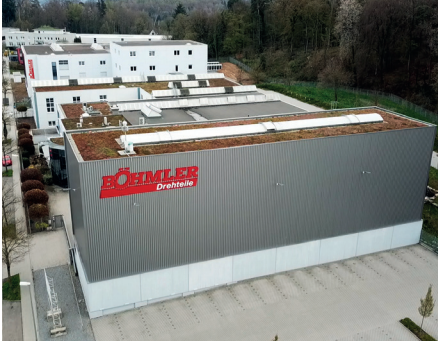
Alle Entwicklungs- und Produktionsbereiche am Firmensitz in Pforzheim entsprechen höchsten Standards, auch in Sachen Nachhaltigkeit.
